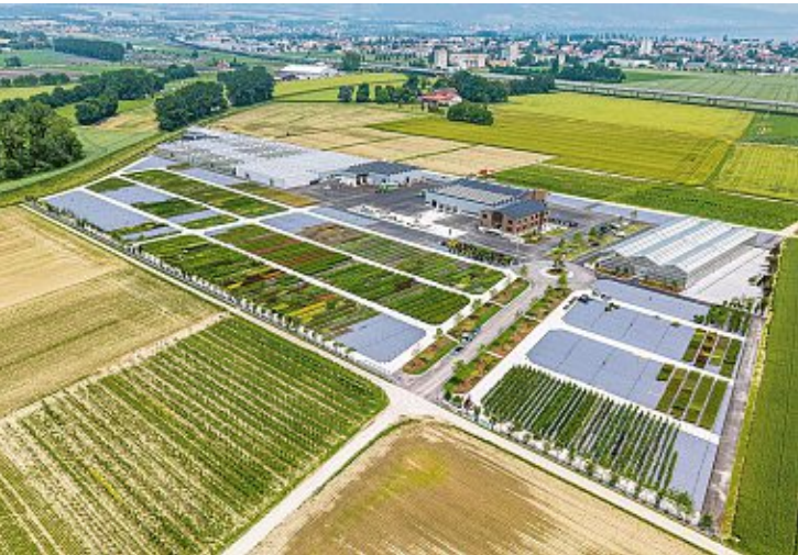
Ouvert depuis début août à Yverdon-les-Bains, le nouveau site des Pépinières Meylan SA est à la pointe des dernières technologies développées dans le secteur. Pépinières Meylan SA
